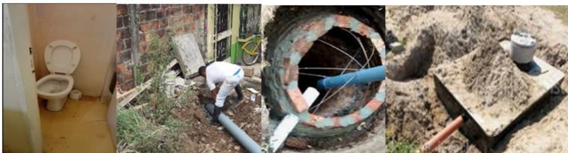
Excusado conectado a pozo ciego
